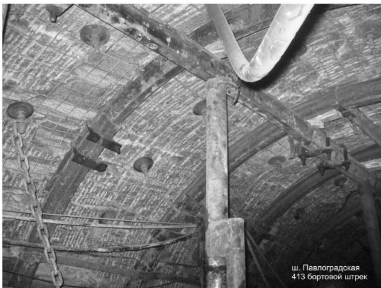
Рис. 3 – Состояние 413 бортового штрека на окне лавы
